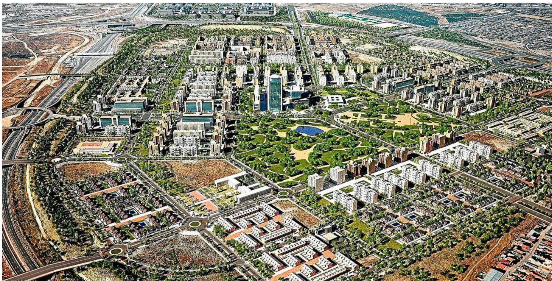
Vista aérea de la recreación de El Cañaveral, que englobará 14.000 viviendas, de las que 6.000 ya están entregadas a sus propietarios o están en construcción. Quedan otras 8.000 por levantar. JUNTA DE COMPENSACIÓN EL CAÑAVERAL
