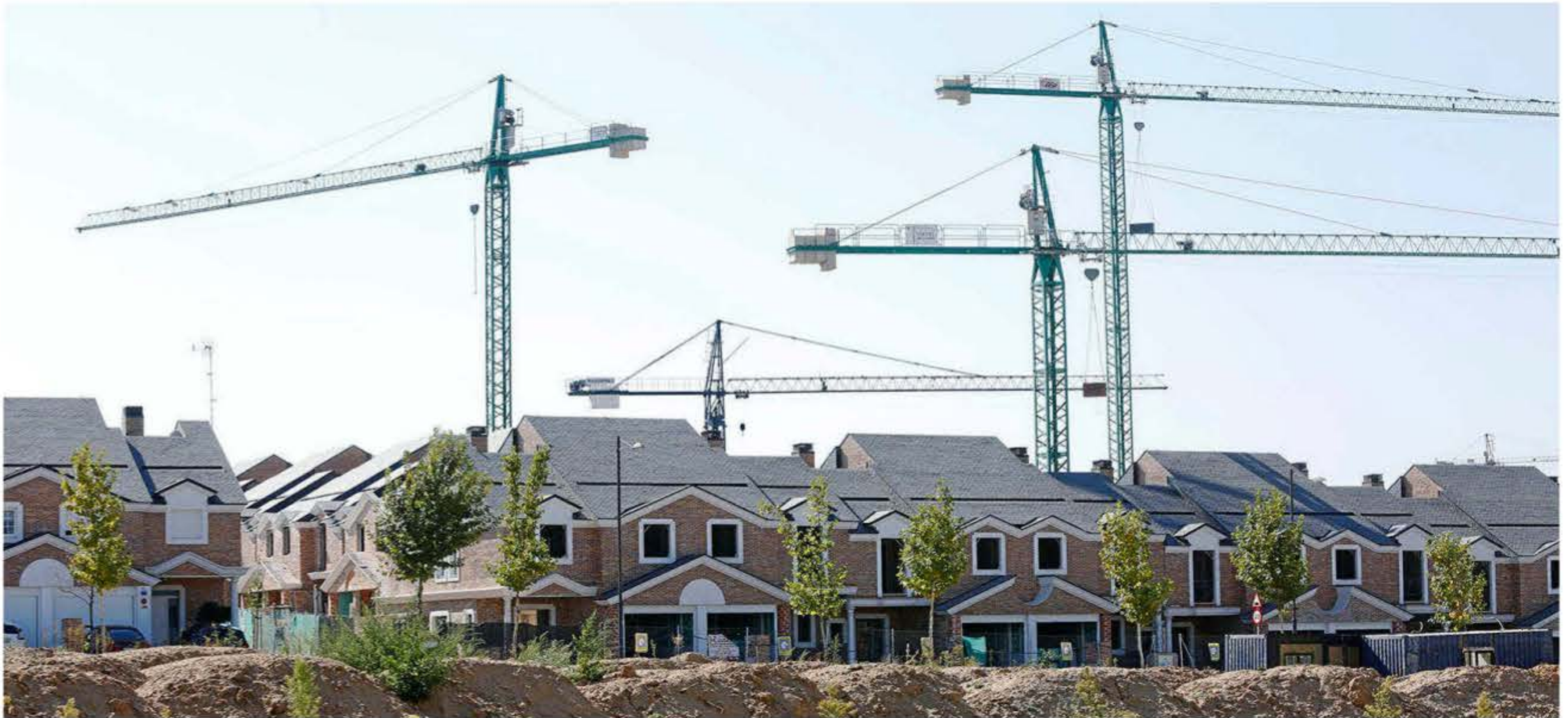
Imagen panorámica de una promoción de viviendas unifamiliares adosadas en su última fase de construcción en Boadilla del Monte. SERGIO GONZÁLEZ
