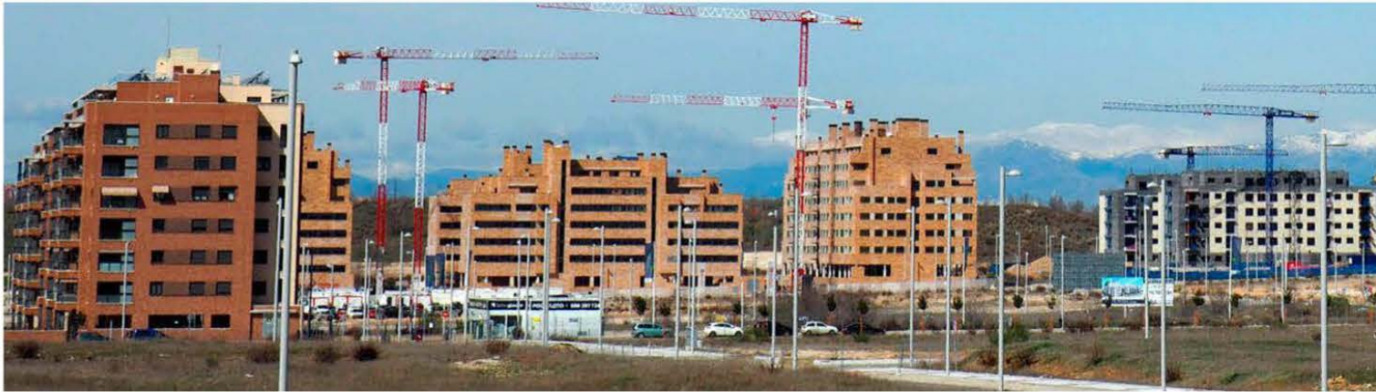
Imagen panorámica de varias promociones de viviendas en construcción en El Cañaveral, el nuevo barrio de Madrid que crece en el sureste de la capital. EL MUNDO
